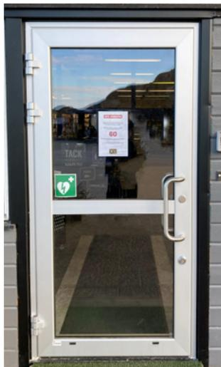
FrontShield™ 66 är ett isolerat system (med bruten köldbrygga) som kan användas för utåt- eller inåtgående dörrar med sido- och överljus samt fasta fönsterpartier.
