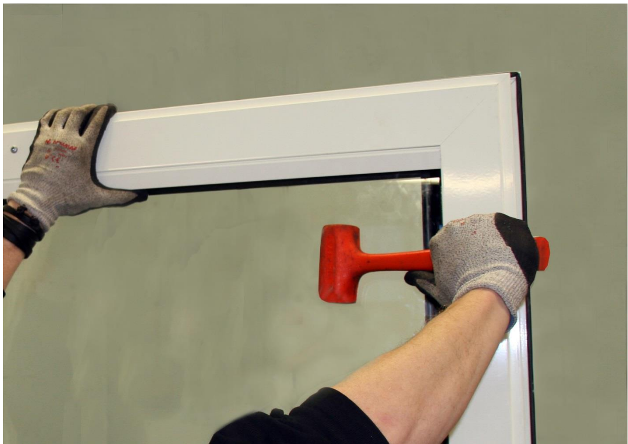
Montera de horisontala glaslisterna.
