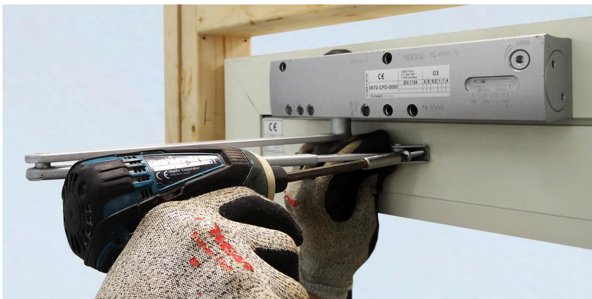
Skruva fast armen i dörrbladet
