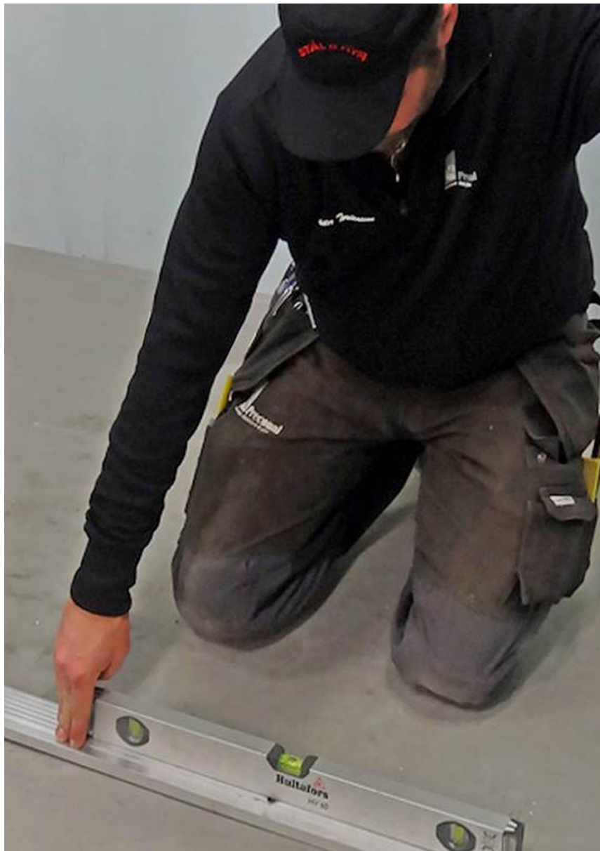
Väg av bottenplattan
