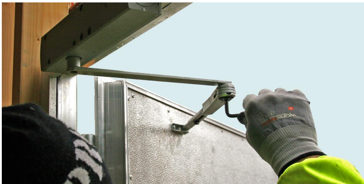
Skruva fast armen i dörrbladet
